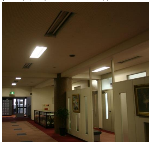
本館1階部分照明の間引き消灯
