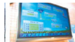
▲1日の発電量がわかる使用電力表示装置
