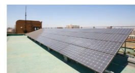
▲本館7階屋上に設置された太陽光発電パネル
